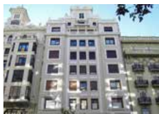
C/MARQUÉS DE SOTELO REHABILITACIÓN EDIFICIO. 2010
