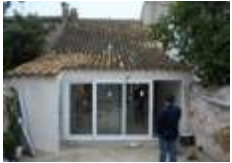
EL REBOLLAR/ VALENCIA REHABILITACIÓN VIVENDA. 2012
