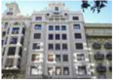
C/MARQUÉS DE SOTELO REHABILITACIÓN EDIFICIO. 2010
