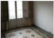
PLAZA PINTOR SEGRELLES REHABILITACIÓN EDIFICIO. 2018
